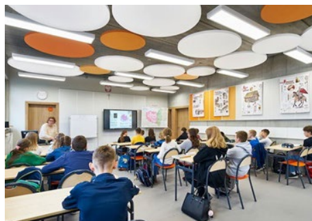
Figura 5.14 - Esempio di applicazione delle isole acustiche Rockfon Eclipse™
